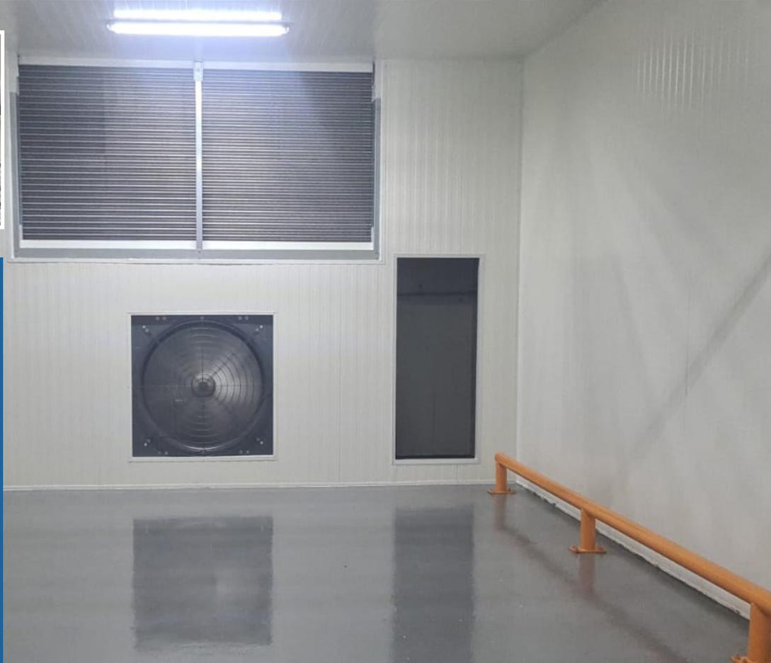
Proyecto de instalación de cámaras y sistema de refrigeración para proceso de aguacate; comprende una cámara de conservación de aguacate de 4 a 5°C, una cámara de proceso de enmallado de aguacate operando a 15°C y dos preenfriados de aguacate con capacidad de 10 palets cada uno.
