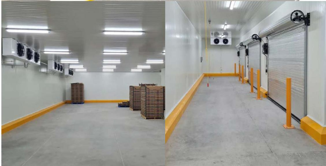
Instalación de refrigeración para empaque completo, consta de tres túneles de preenfrio doble flujo 40 hp, capacidad 16 pallets cada uno, temperatura salida producto 0 a 2°C, un pasillo de tránsito refrigerado, cámara conservación de 100 pallets a 2°C, andén de embarque refrigerado a 5°C y una antecámara operando a 10°C.
