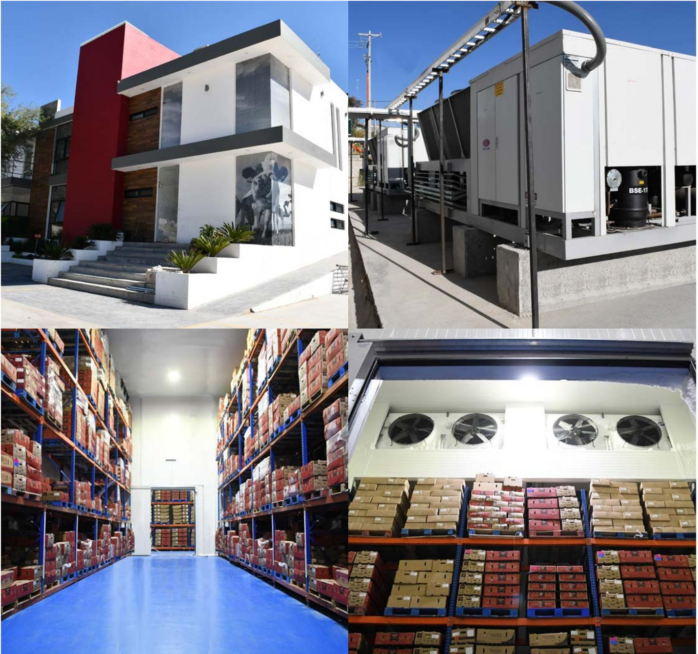
Instalación de cámara con un área de 250m<sup>2</sup>, conservación de congelados operando a -18°C, un congelador rápido equipado con una unidad de 30 hp y evaporador de alto perfil, capacidad de 5 Toneladas en 44 horas, temperatura promedio salida de producto -18°C.
