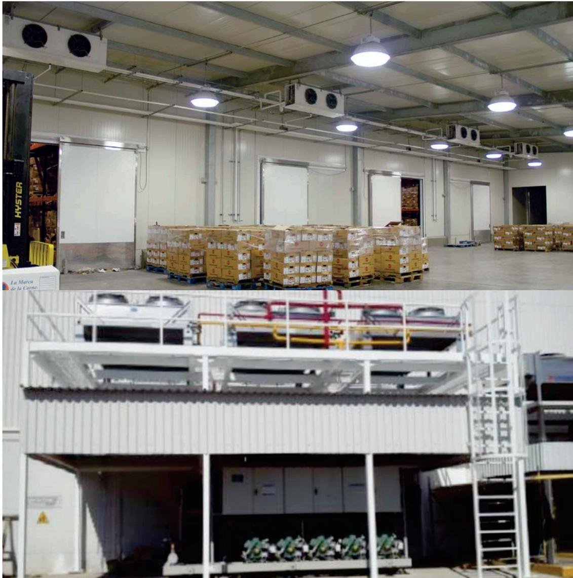
Suministro e instalación de equipos de refrigeración para cámaras diversas, compuestas por racks de compresores para el área de congelación y área de andén.
